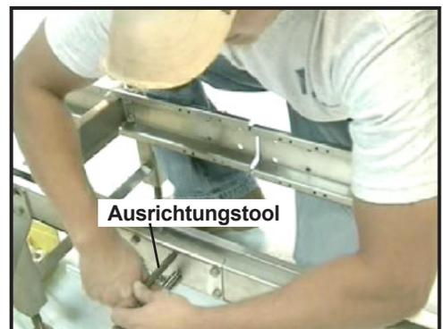
**Abbildung 6:** Wenden Sie das Ausrichtungstool an (im offenen Loch), um Ladeflächenabschnitte zusammenzuziehen
